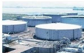
石油貯蔵タンク
